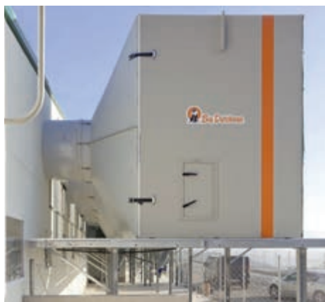
Змонтовано на централізовану систему подачі припливного повітря
